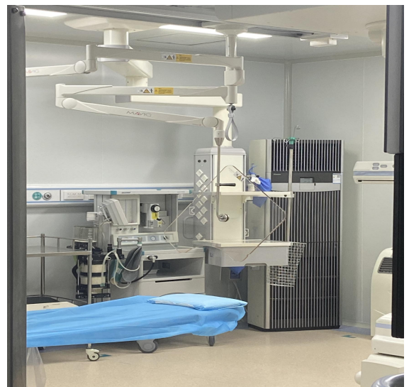
照片 11 悬挂铅屏风
